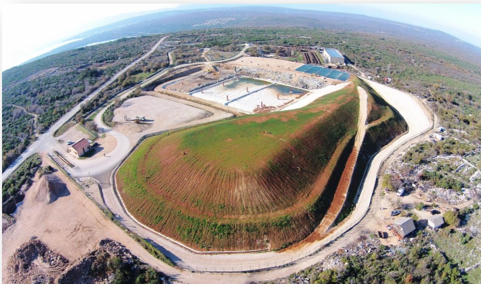
Slika: Odlagalište otpada Treskavac, nakon sanacije
