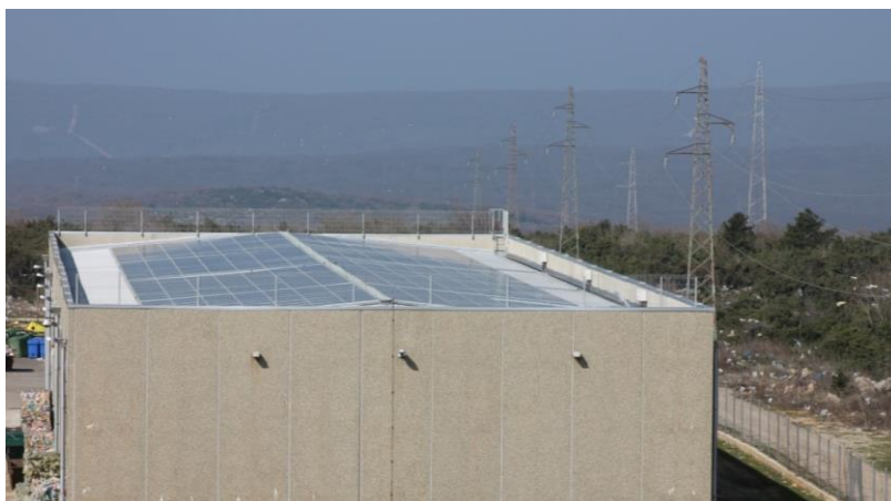
SLIKA: Krov hale Treskavac sa fotonaponskim postrojenjem.
